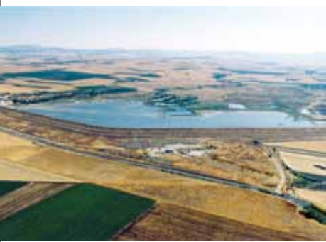
Diga Capaccio sul Celone.
