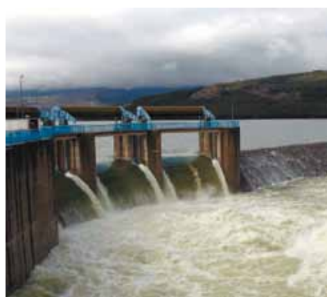
Diga di Occhito. Scarico di superficie.
