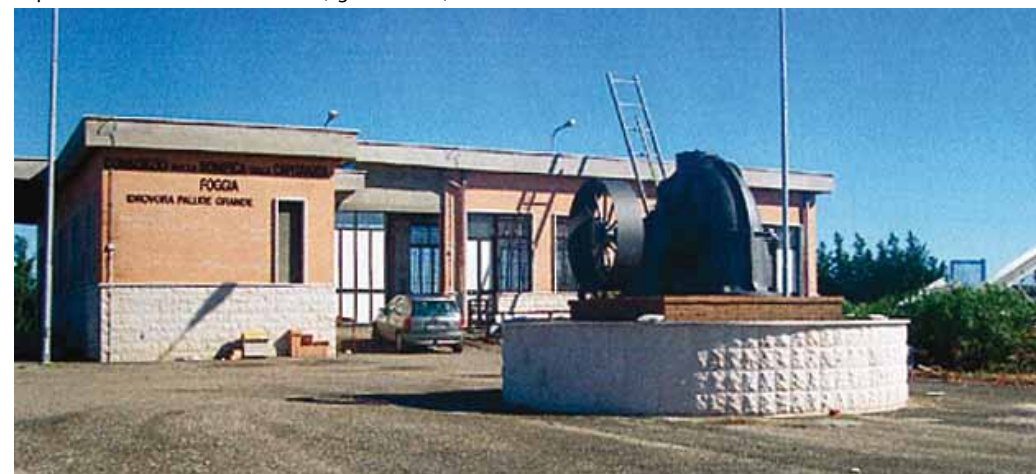
Impianto idrovoro di Palude Grande (agro di Lesina).
