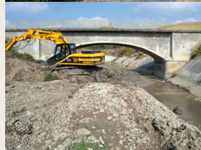
Interventi di manutenzione ordinaria e straordinaria sui canali di bonifica.
