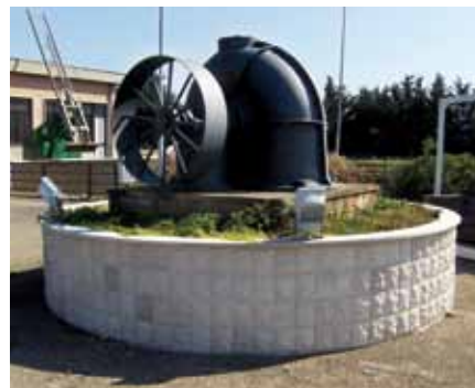
Impianto Palude Lauro. Idrovora Riva Calzoni degli anni '30.
